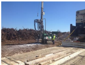
Travaux de création du forage en avril 2015
