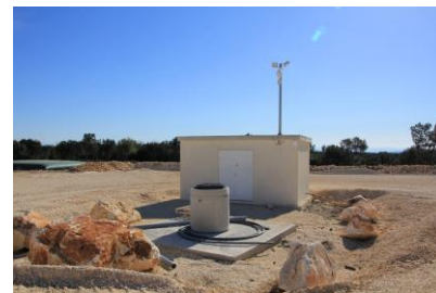
Forage à l'issue des travaux
